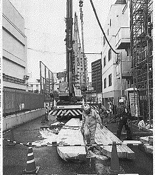
日刊木材新聞社の建築で大梁を揚重する
